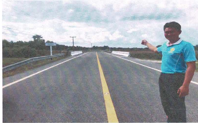
ถนนเส้น ปากทางบ้านแดงโพง-สี่แยกบ้านนาฝาย
